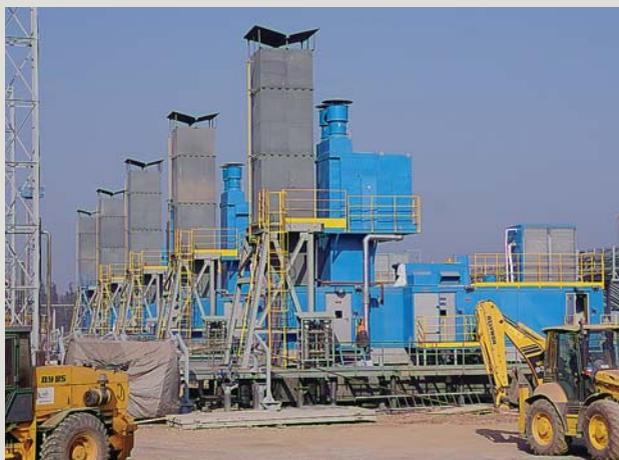
Монтаж пяти газотурбинных электростанций ГТЭС-2,5 на Ковыктинском газоконденсатном месторождении
