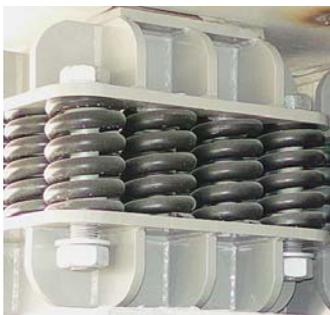
Фото 1. Пружинный виброизолятор марки ТК
