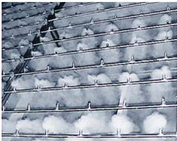
Фото 1. Установка форсунок для газовой турбины 7FA General Electric
