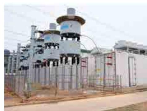
Рис. 3. Компенсирующее устройство на базе управляемого источника напряжения типа СТАТКОМ
