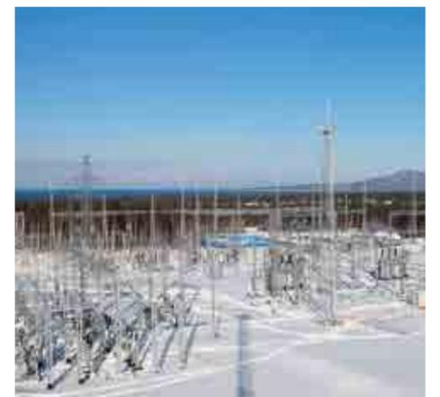
повышенной сейсмической активности в регионе. Установленная мощность энергообъекта составляет 250 МВА. При строительстве ОРУ 110 и 220 кВ впервые в России использованы инновационные компактные модульные ячейки, каждая из которых состоит из элегазового выключателя с двумя разъединителями и двумя заземлителями. Применение данных ячеек снижает до минимума необходимость технического обслуживания.
