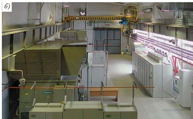
Фото 1. Общий вид компрессорной станции (а) и компоновка оборудования лидерного ЭГПА-4,0/8200-56/1,26-Р на КС «Володино» (б)
