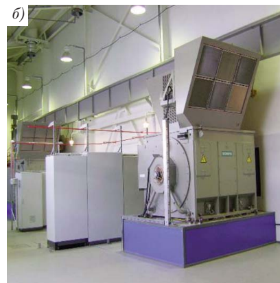
Фото 5. Электродвигатель мощностью 6,3 МВт на испытательном стенде (а), мощностью 4 МВт – в компрессорном цехе КС «Володино» (б)
