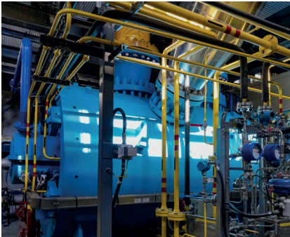
Рис. 1. Центробежный компрессор смешанного хладагента K905-71-1C на заводе СПГ Криогаз - Высоцк
