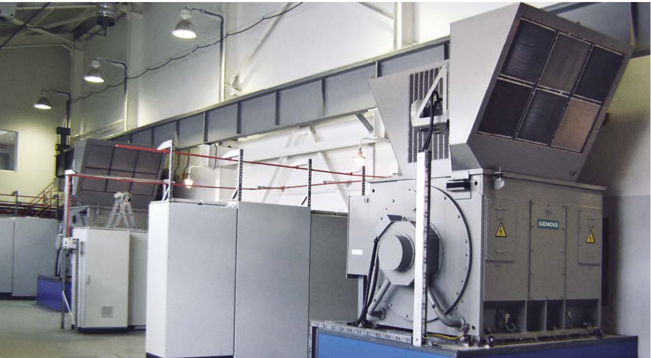
Высокоскоростной электродвигатель на КС Александровская
