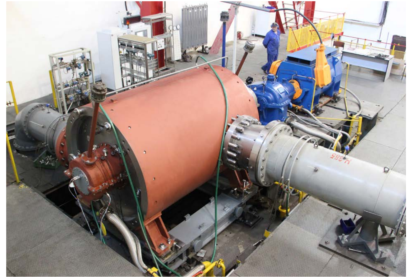
Испытательный стенд центробежных компрессоров
